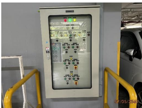
ภาพที่ 2.2-8 ตู้ไฟระบบบำบัดน้ำเสีย
