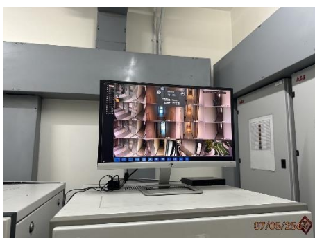
ภาพที่ 2.2-49 ระบบโทรทัศน์วงจรปิด (CCTV System)
